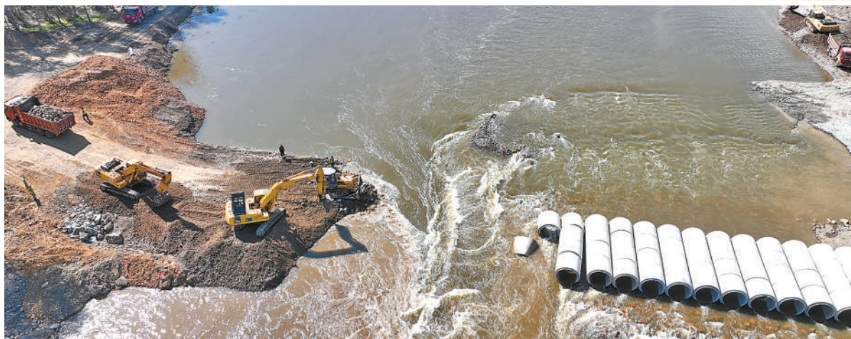
8月17日,黑龙江省海林市新安朝鲜族镇山咀子大桥遭遇水毁后,施工团队修建临时便道,为当地群众解决出行问题。
