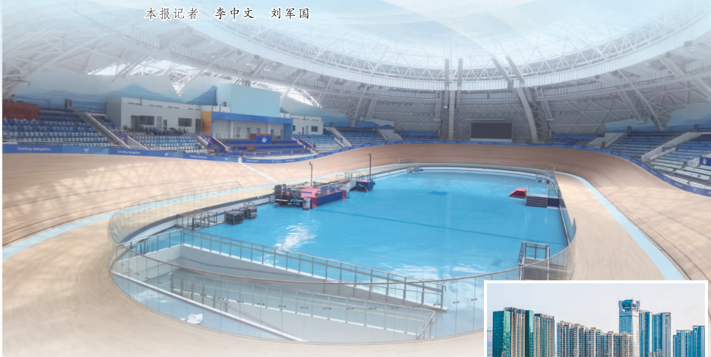
▲杭州淳安赛区的场地自行车馆斜坡式木赛道,面层由租赁的374片赤松拼接而成。
