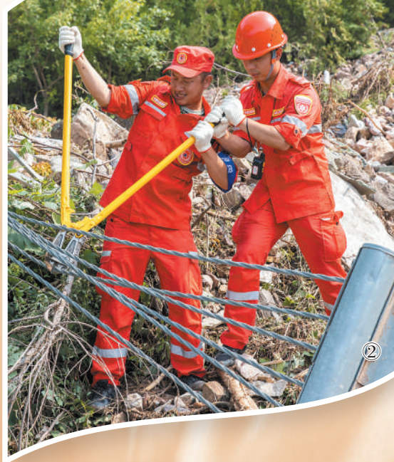
图①：8月15日，天津市静海区台头镇，由应急抢险专家、基层党员、干部等组成的应急抢险队顶着烈日巡护、排查堤坝风险。
