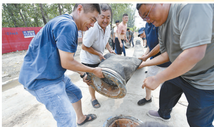
8月17日,在河北省廊坊市文安县口头村,党员志愿者正在安装大型抽水泵,排出村内低洼地段的积水。
