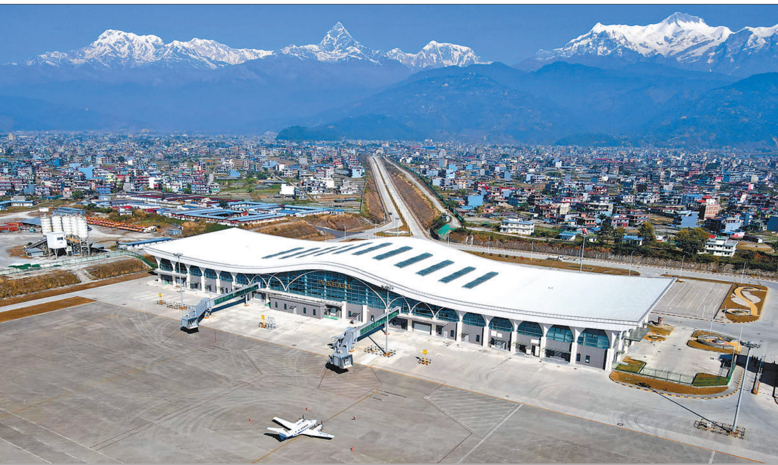
尼泊尔博克拉国际机场项目由中工国际工程股份有限公司承建。该机场是中尼两国重点合作项目,也是建设跨喜马拉雅立体互联互通网络的重要组成部分。机场于今年年初投入运行,并于6月21日迎来首架中国航班。图为博克拉国际机场候机楼远景。吴琪摄
