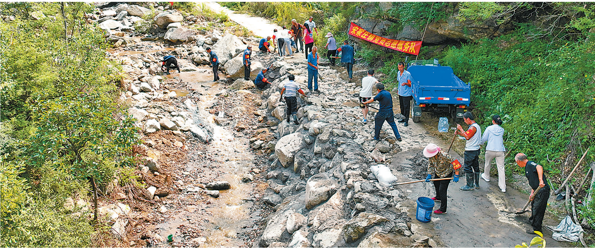
8月15日,河北省邢台市信都区宋家庄镇甄家庄村党员群众组成的抢险队,在村北侧抢修山场路。
