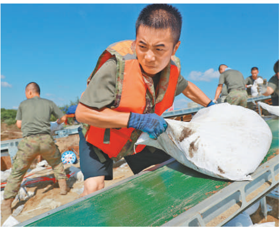
8月15日,陆军第78集团军某旅党员突击队在吉林省扶余市拉林河杨家崴子段加固堤坝。
