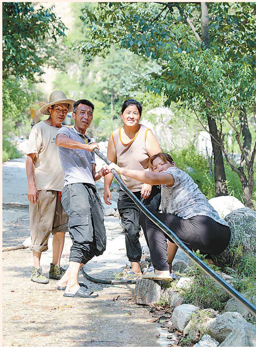
8月13日，河北省石家庄市灵寿县南营乡杨家村，干部群众抢修供水管网。邵玉姿 史晨全摄影报道
