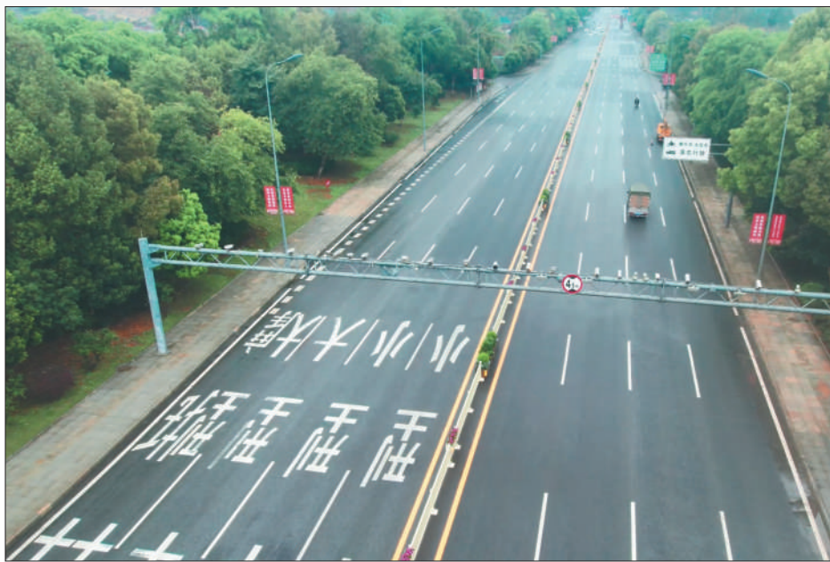
重庆市公安局交巡警总队多次到璧山区黛山大道调研,分析交通事故多发原因并提出解决方案。图为落实安全隐患排查整改后的黛山大道。 邹璇摄(人民视觉)
