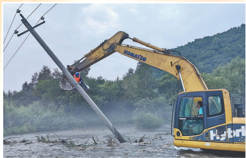
8月9日,在吉林省汪清县八人沟农场,国网吉林电力公司共产党员服务队在线抢修停电线路。 卜育石 健摄影报道
