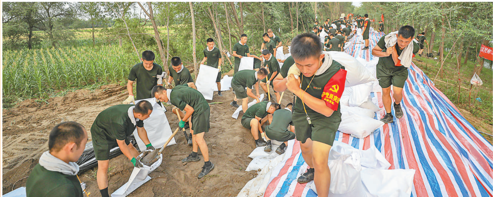
日前,武警天津总队机动支队官兵在静海区子牙河独流镇段加固堤坝。 胡东润摄(人民视觉)
