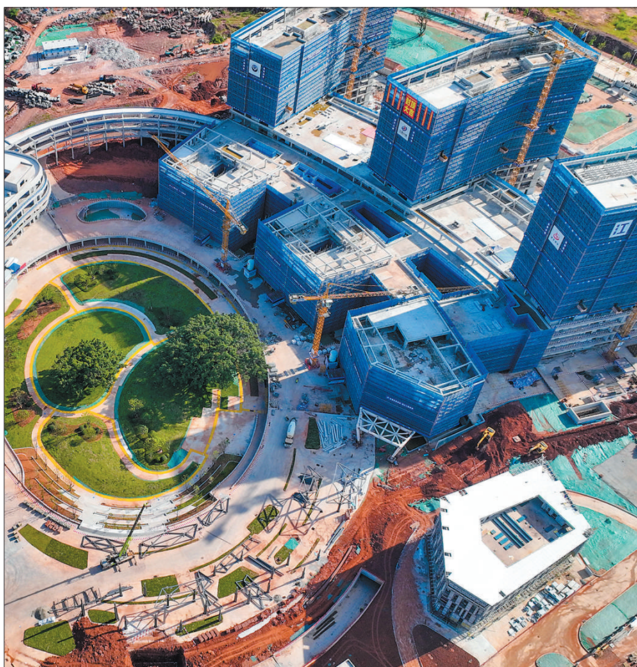
江西省赣州市章贡区,在广东省人民医院赣州医院(沙河院区)项目施工现场,各项作业正紧张有序推进。
