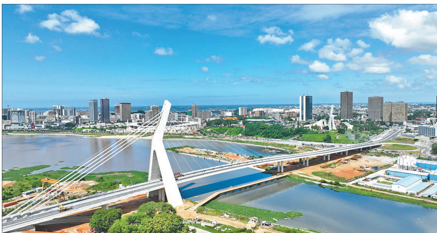
8月12日，由中国路桥工程有限责任公司承建的科特迪瓦经济首都阿比让科特迪瓦科拉桥项目竣工通车。科特迪瓦项目主线总长约1.63公里，其中主桥为钢槽梁单塔斜拉形式，全长630米、主跨长200米、主塔高108.6米。科特迪瓦总统瓦塔拉当天在出席大桥竣工仪式时感谢中国企业为修建大桥作出的贡献。他表示，大桥通车将有效缓解阿比让市区交通拥堵的现状，是改善民生的高品质工程。
