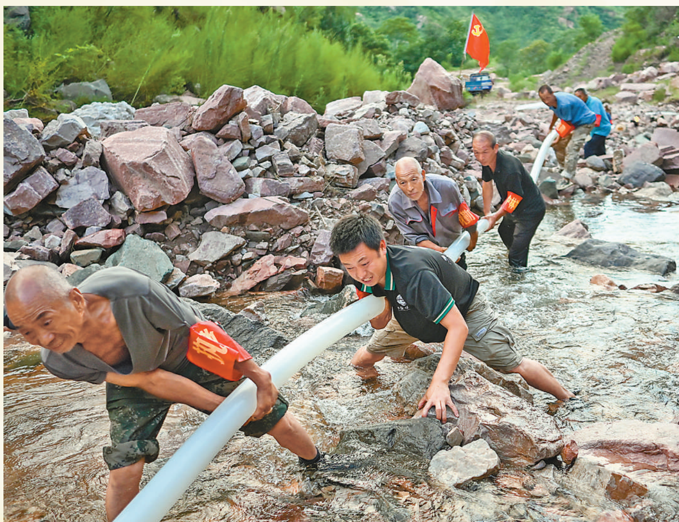
8月5日，河北省石家庄市井陘县洲鱼村党员干部带领群众奋力抢修供水管网。邵玉姿 赵 威摄影报道
