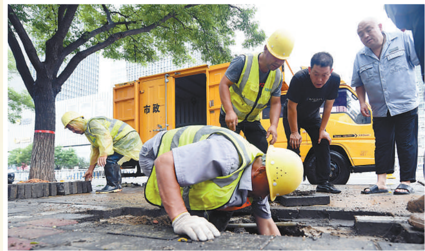
8月10日,河北省廊坊市市政人员抢修因暴雨破裂的管道。 邵玉姿 孙宝宇摄影报道
