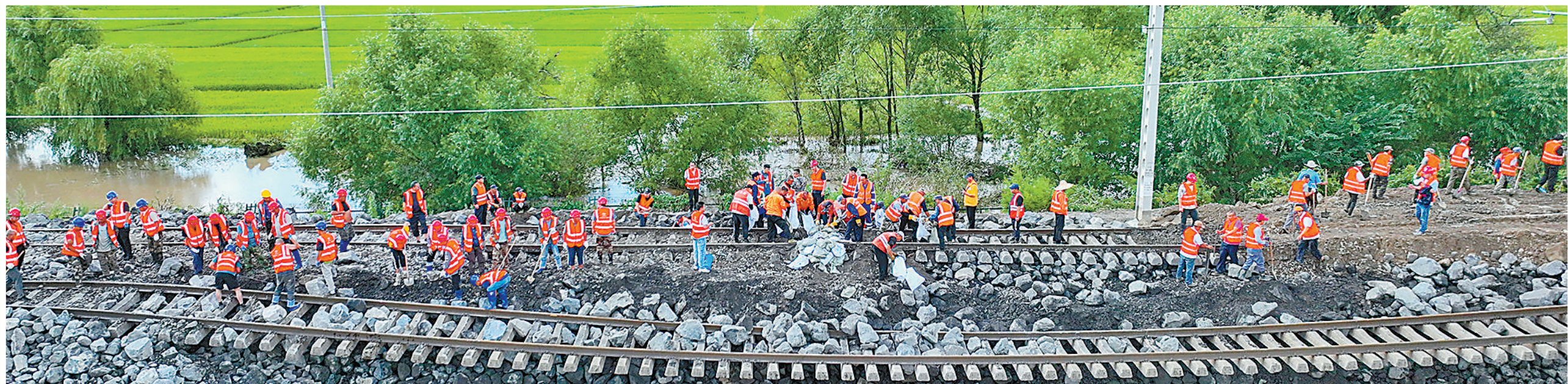
8月8日,中国铁路哈尔滨局集团有限公司抢险人员对铁路线路及设备开展集中抢修。
