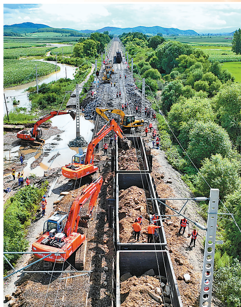
8月8日,中国铁路哈尔滨局集团有限公司抢险人员紧急动员,对铁路线路及设备开展集中抢修。 原勇摄(人民视觉)
