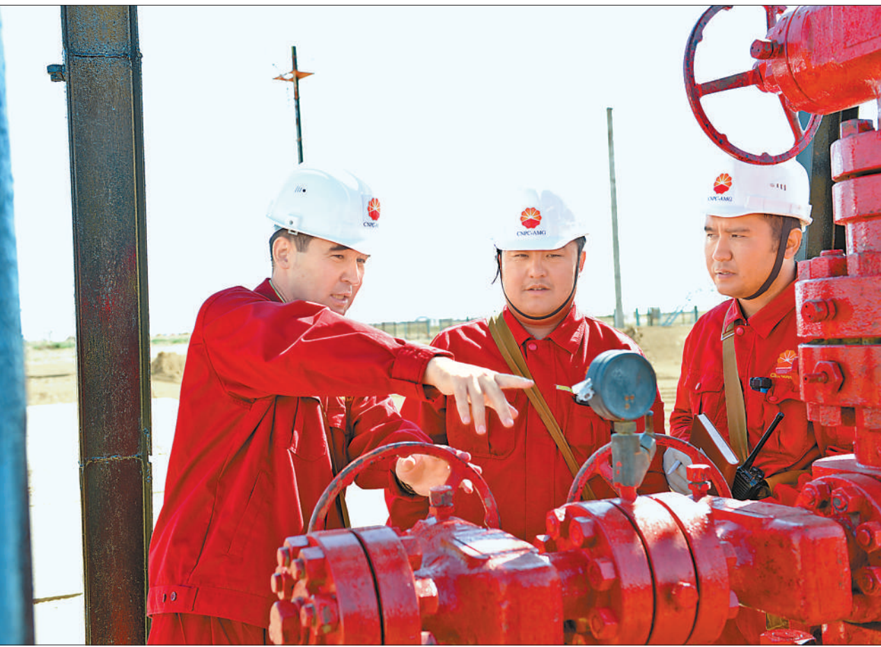
中石油(哈萨克斯坦)阿克纠宾项目员工在项目现场作业。
