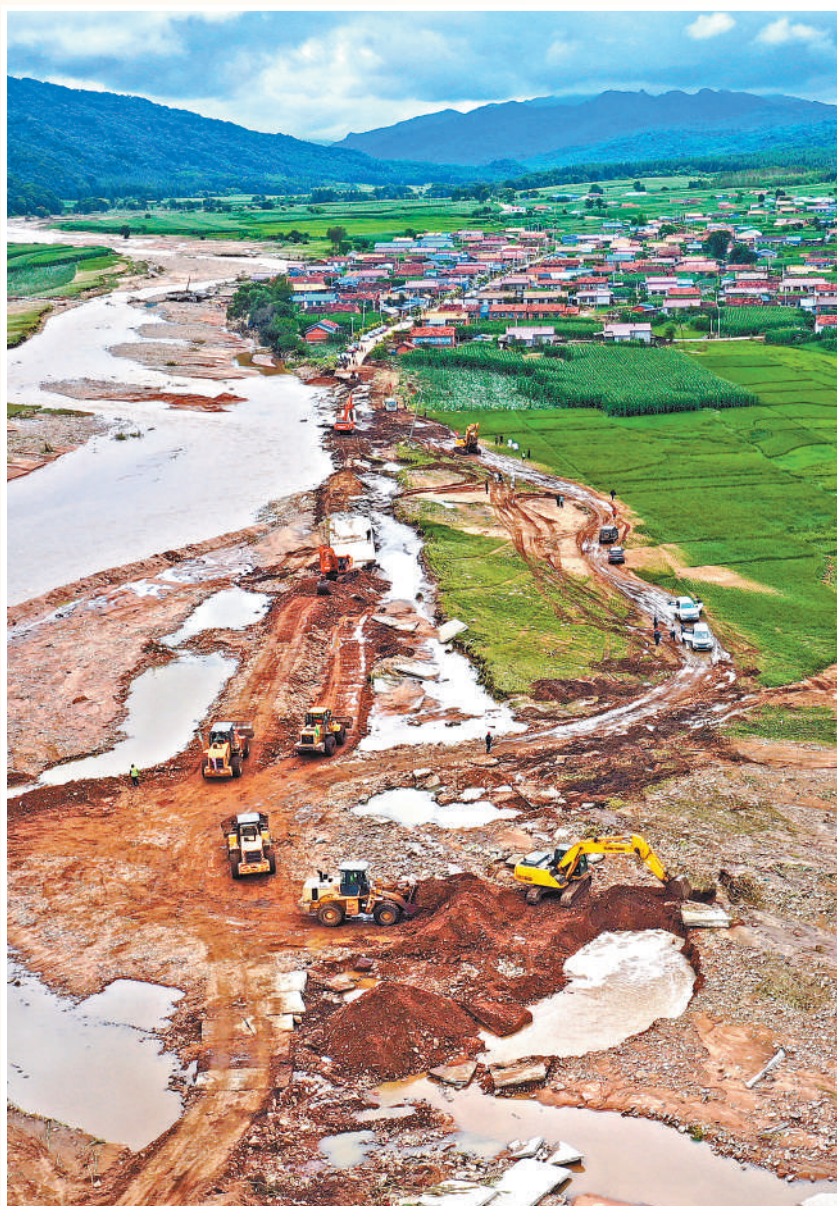
8月6日,在通往吉林省舒兰市青松林场的村道上,大型机械在抢修水毁道路。 刘以晴 闫斌摄影报道
