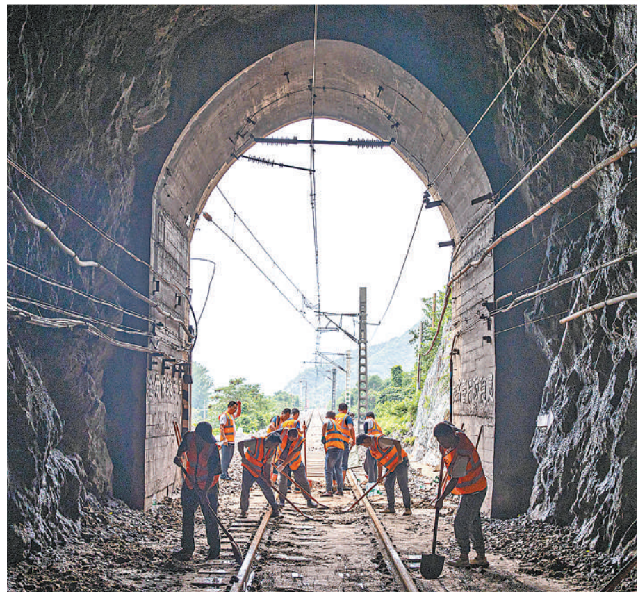
8月7日,北京市门头沟区王平镇,中国铁路北京局北京西工务段工作人员在清理路基和轨道。 本报记者 张武军摄
