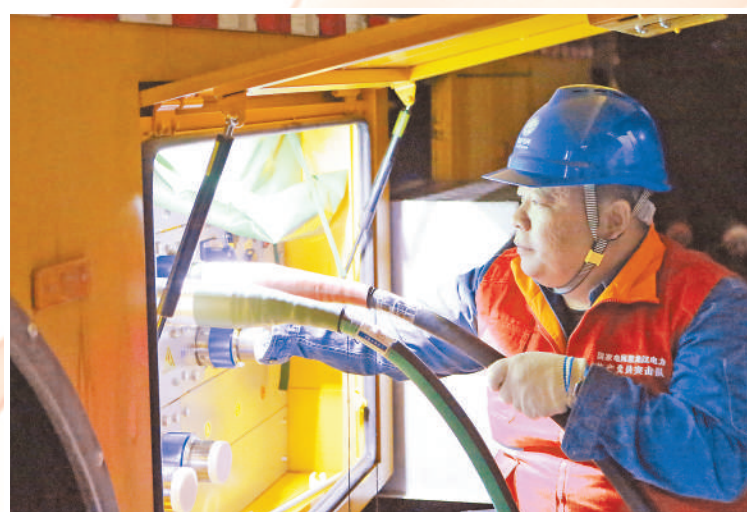
8月8日,黑龙江省牡丹江供电公司抢修人员在为10千伏级应急电源车连接线路。 方圆 任海霞摄影报道
