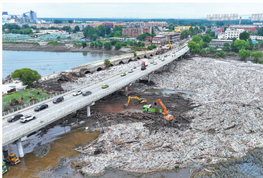
8月7日,北京市房山区琉璃河桥,大型机械在清理水面漂浮物,疏通河道。 本报记者 雷声摄
