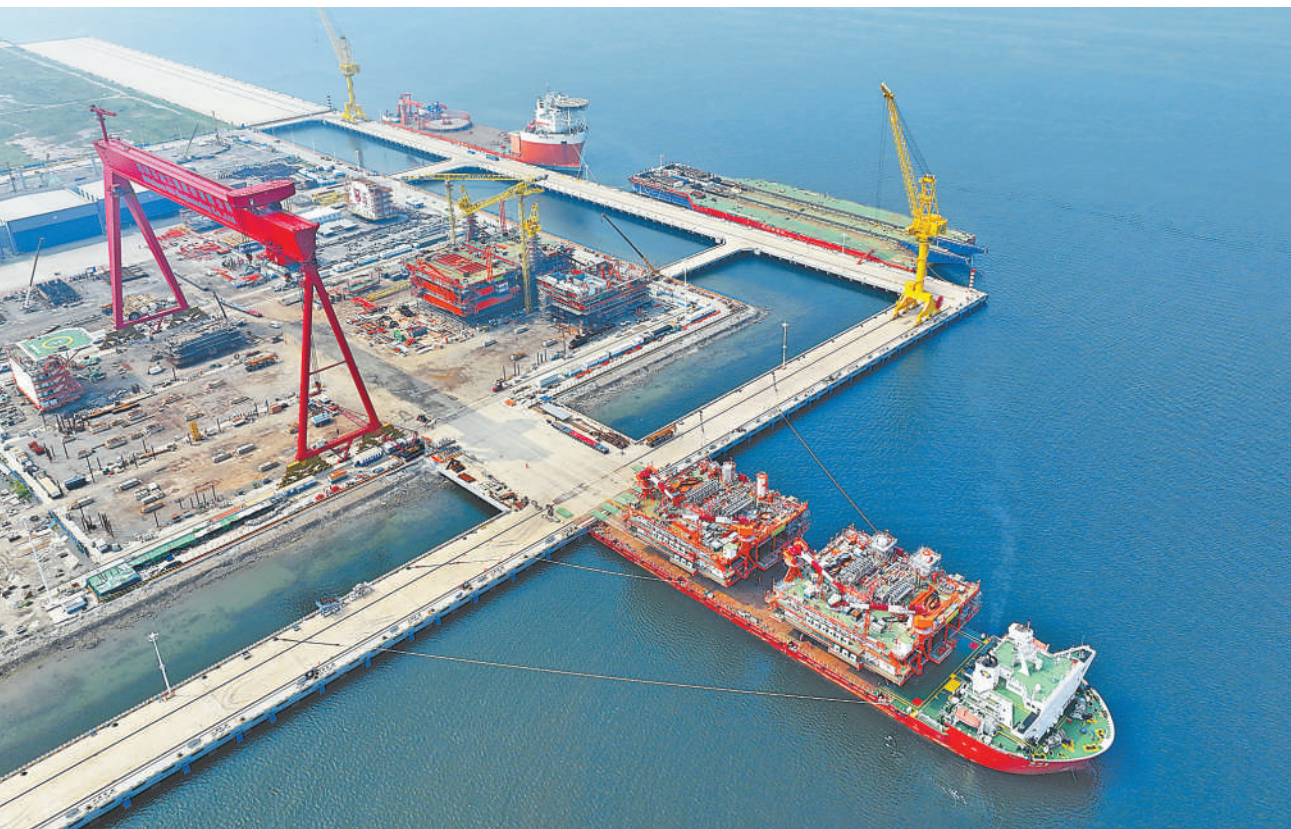
渤海首个千亿方大气田I期项目海上平台建造完工
