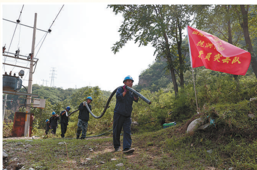
8月8日,国网河北涞水县供电公司党员突击队队员在三坡镇下庄村拒马河畔搬运电缆。
