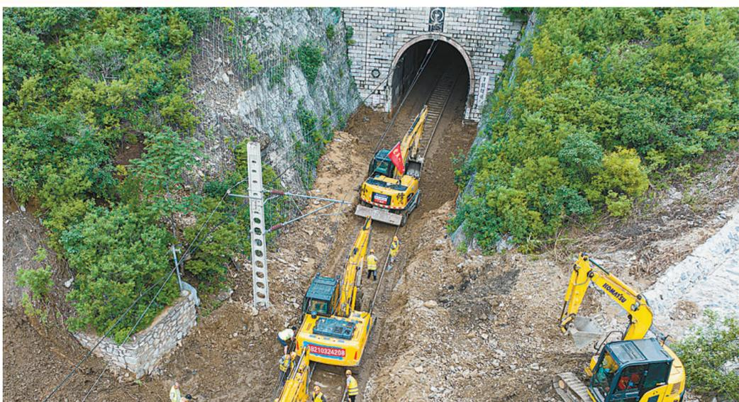
8月7日，中国铁路北京局北京西工务段抢险人员在党员突击队带领下，清理丰沙上行线7号隧道丰台方向出口的钢轨线路。
