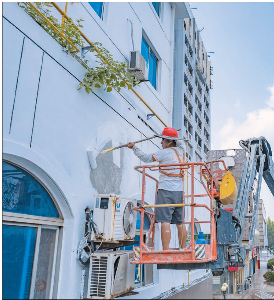
江苏省宿迁市宿城区幸福街道东大社区一老旧小区，工人正在粉刷外墙。
