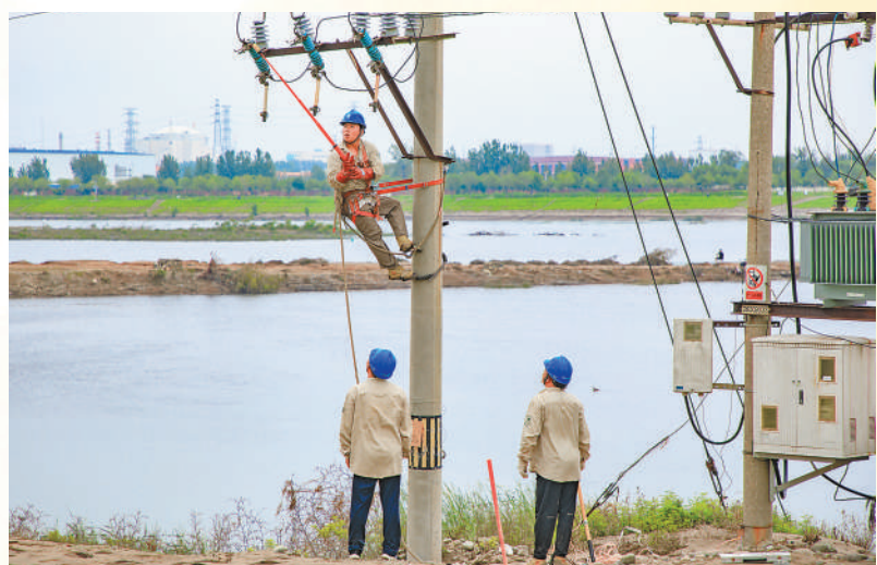
日前，国网北京石景山供电公司抢修人员在北京市房山区羊头岗村抢修受损电力线路。李强摄
