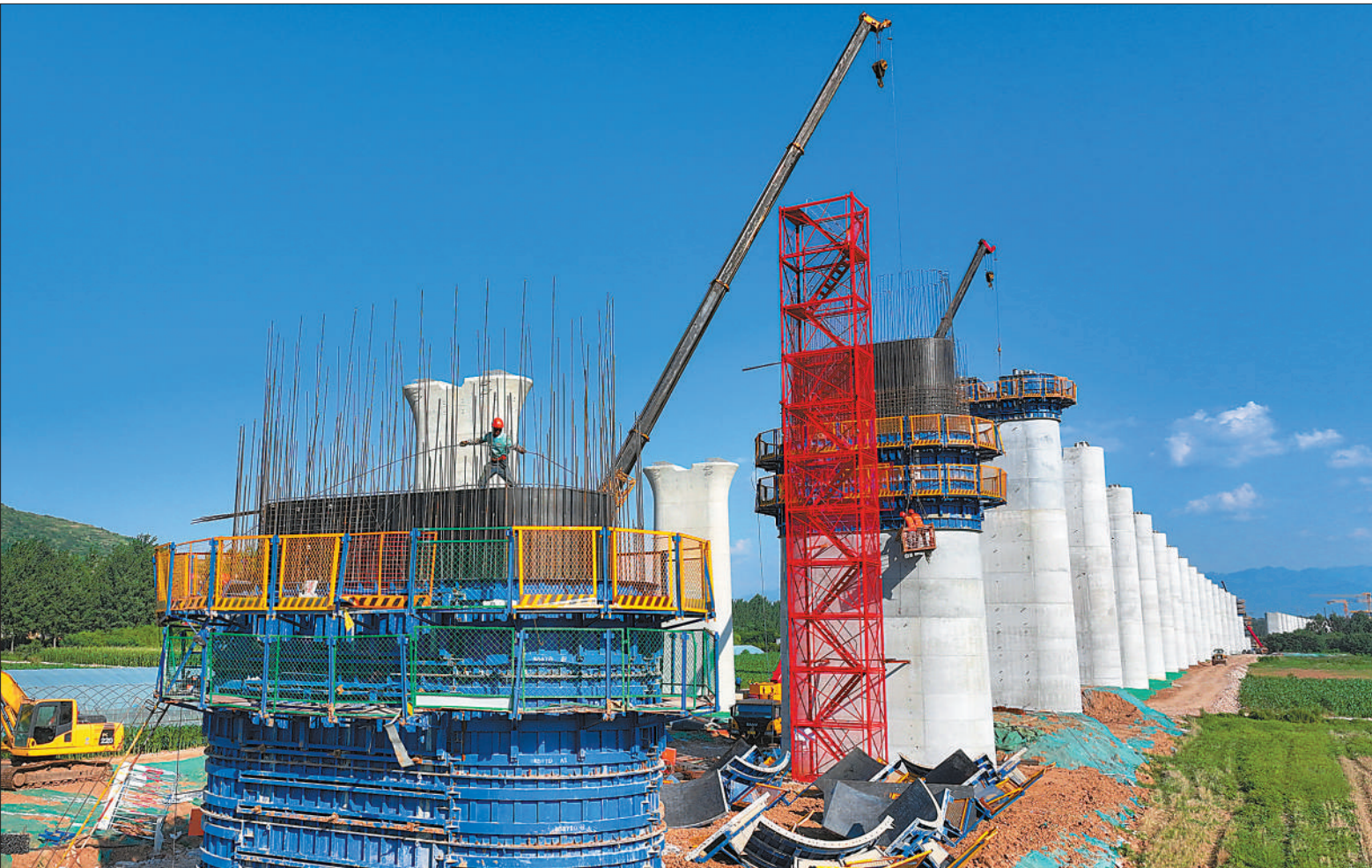
西康（西安—安康）高铁是国家中长期铁路网规划中“八纵八横”高速铁路网包海（包头—海口）通道的重要组成部分，全长约171公里，设计时速350公里，计划建设工期5年，目前项目建设按计划有序推进。图为西康高铁西安长安区站前工程建设施工现场。本报记者 雷声摄
