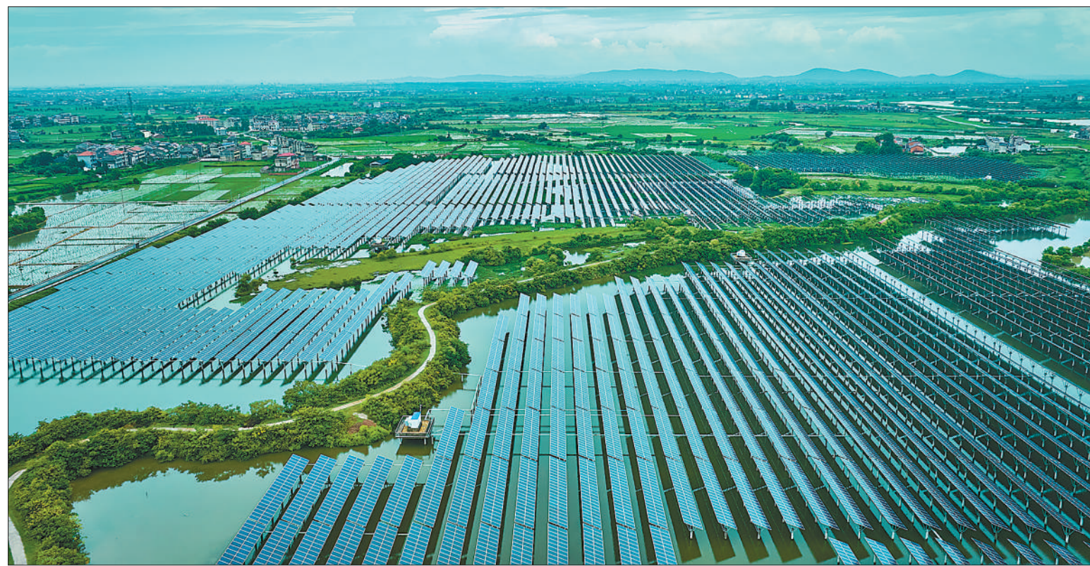
江西省南昌县黄马乡官田村充分利用坑塘水面,将光伏产业与养殖业相结合,实现水上发电、水下养殖协同增效。图为官田村渔光互补光伏电站。史家民摄(人民视觉)
