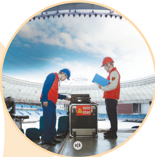
图①：国家电网成都大运会电力保障团队在东安湖体育公园开展用电检查。
