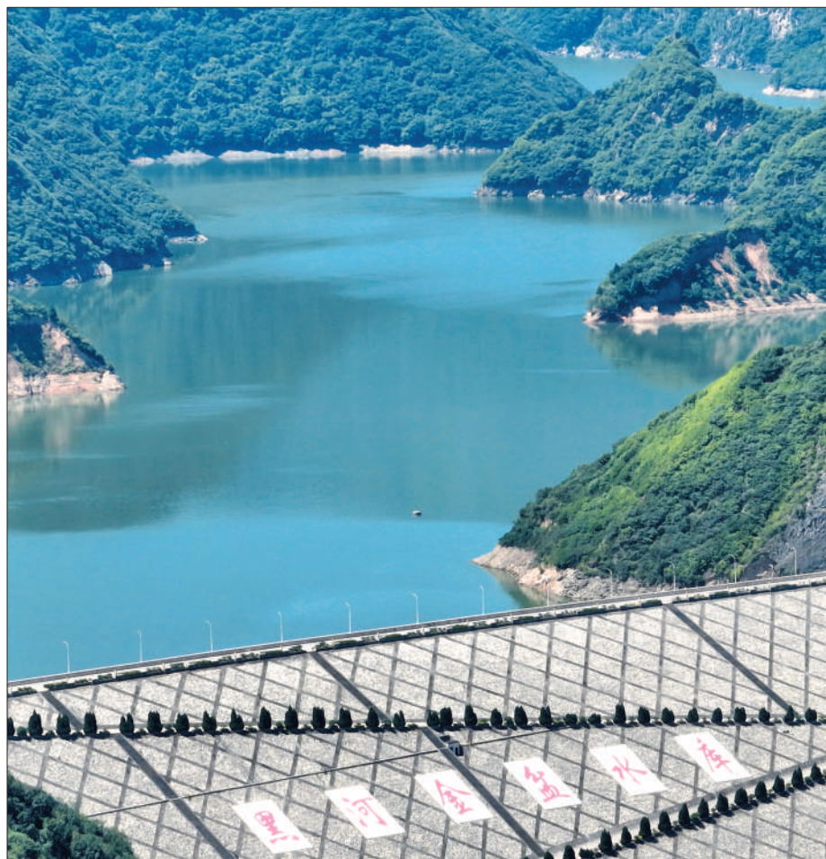
引汉济渭工程引来的汉江水通过黑河金盆水库西安供水管线向西安市先期供水。 新华社记者 邵瑞摄
