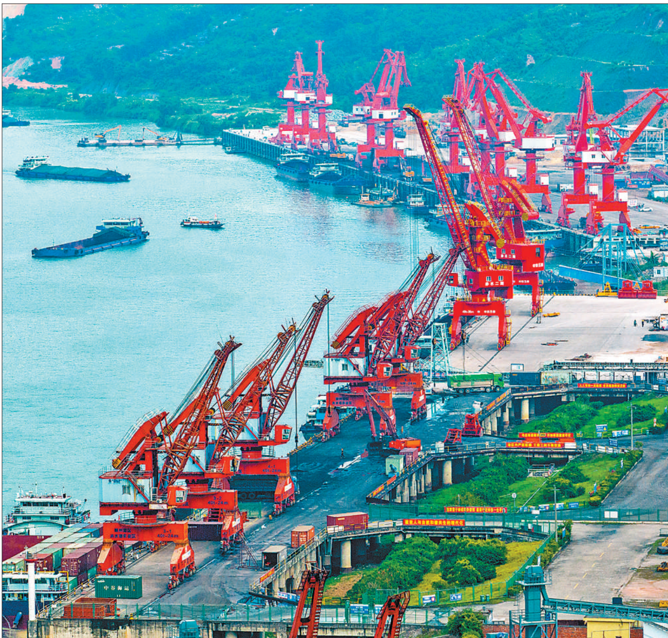
作为集铁、公、水、空港于一体的大型内河综合性码头，广西梧州临港经济区赤水港码头是西江经济带走廊重要的港口作业区，可直接为柳州、贺州、玉林、南宁、贵港等地的企业及物流贸易商提供快捷高效的物流中转通道。图为近日，赤水港码头卡车往来穿梭，船舶正在进行装卸作业，现场一片繁忙。
