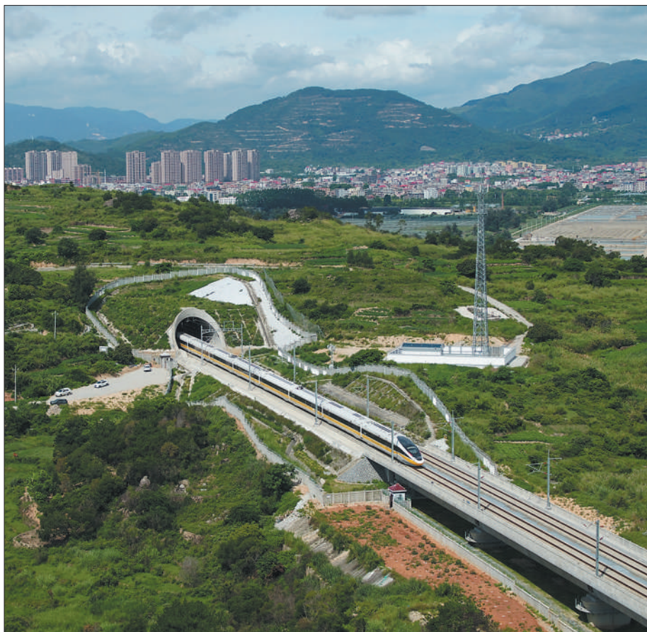
CR450新一代动车组试验列车驶过福厦高铁福清至泉州区段海尾隧道。新华社发
