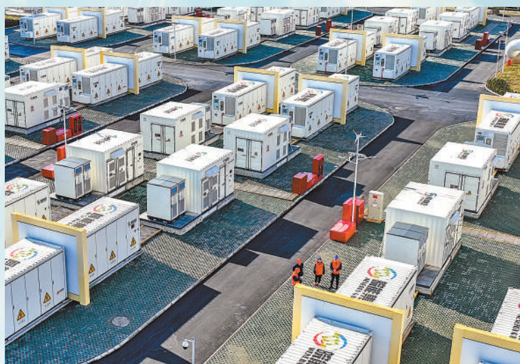
安徽省淮北市,电力技术人员对淮北皖能储能电站进行并网测试。王文摄(人民视觉)
