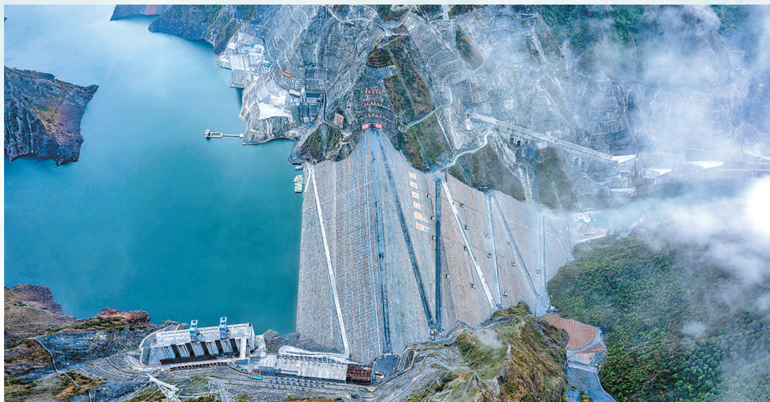
近日,位于四川省甘孜藏族自治州的雅砻江两河口水电站水光互补一期项目——柯拉光伏电站并网发电,实现光伏发电和水力发电的“打捆”送出。新华社记者 薛晨摄
