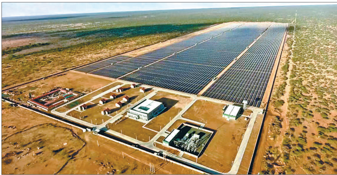
位于肯尼亚东北部的加里萨五十兆瓦光伏电站，是肯尼亚规模最大的光伏发电项目，由中国江西国际经济技术合作有限公司设计承建。并网发电后，有效缓解了肯尼亚用电荒，助力当地经济可持续发展。柯塔柏摄
