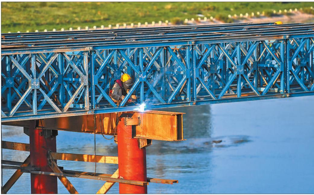
7月12日傍晚,江西省宜春市袁山二桥新建工程项目现场,施工人员在搭建栈桥。连日来,宜春持续高温,施工单位强化防暑保障,实施错峰作业,安全有序施工,确保工程进度顺利推进。
