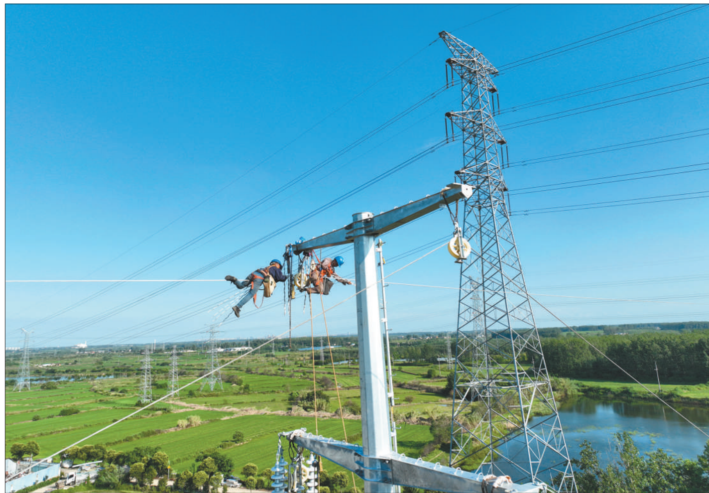
日前，在迎峰度夏关键时期，为保障电力供应，国网安徽电力组织人员对线路进行维护，提升保供能力。图为电力工人在合肥长丰县陶楼镇开展检修作业。刘兵摄(人民视觉)
