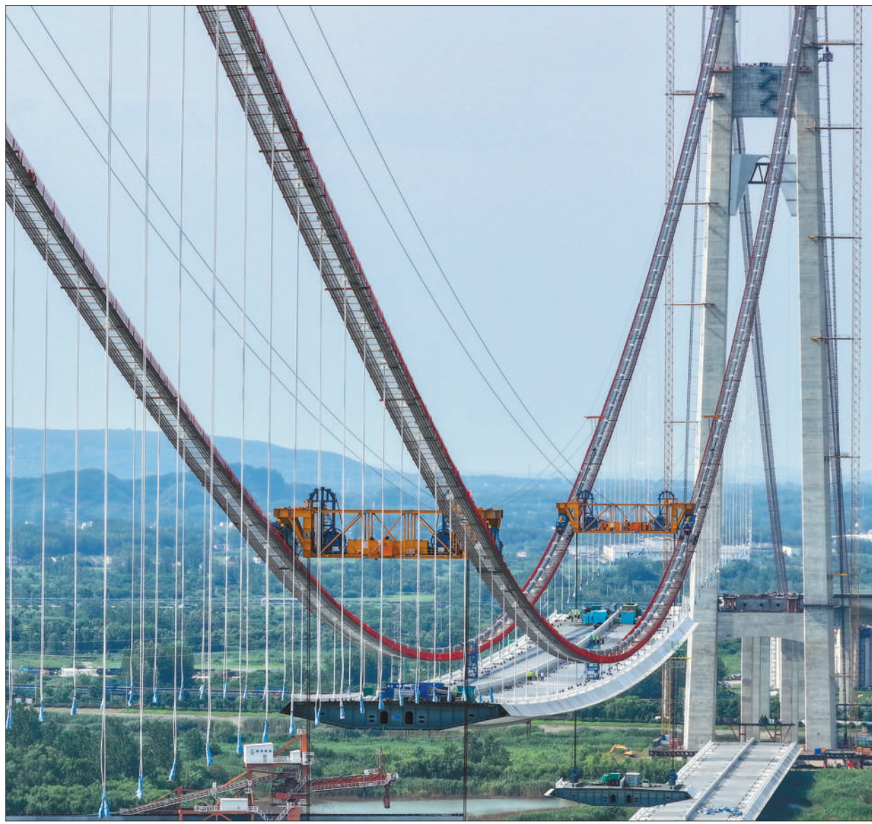
7月10日，江苏南京仙新路过江通道钢箱梁吊装稳步推进，大桥已进入上部结构安装阶段。南京仙新路过江通道是连接南京主城区栖霞区与江北新区、南京经济技术开发区的重要纽带，全长约13.5公里。图为建设者在南京仙新路过江通道进行钢箱梁吊装施工。 方东旭摄（影像中国）
