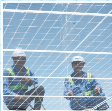
港区工人清洁屋顶光伏板，影子映在光伏板上。 本报记者 李 舸摄
