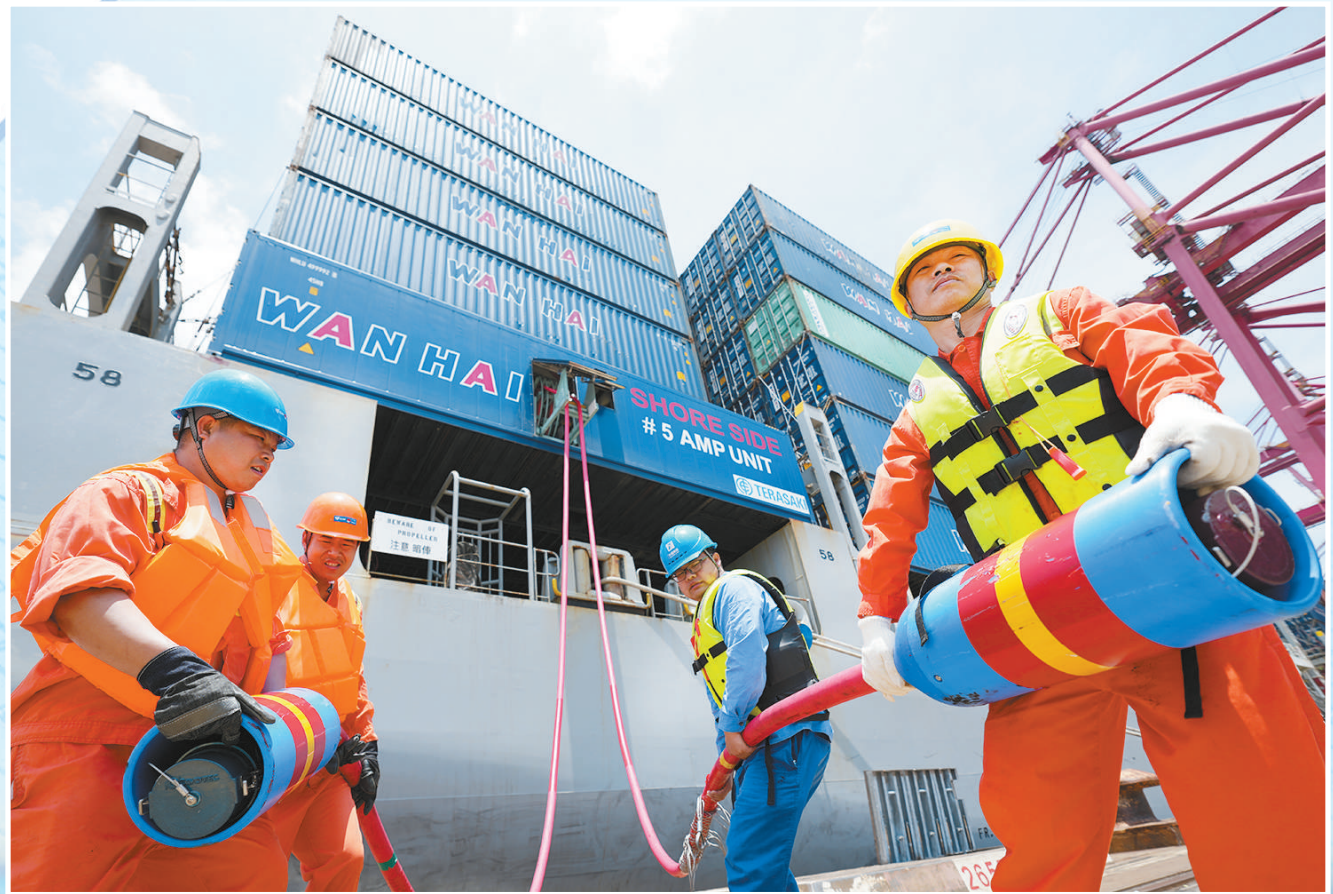
工人将船舶电缆接入港区岸电设备。 本报记者 李 舸摄
