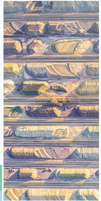
宁波舟山港鼠浪湖矿石中转码头堆场。 沈 骊摄(人民视觉)
