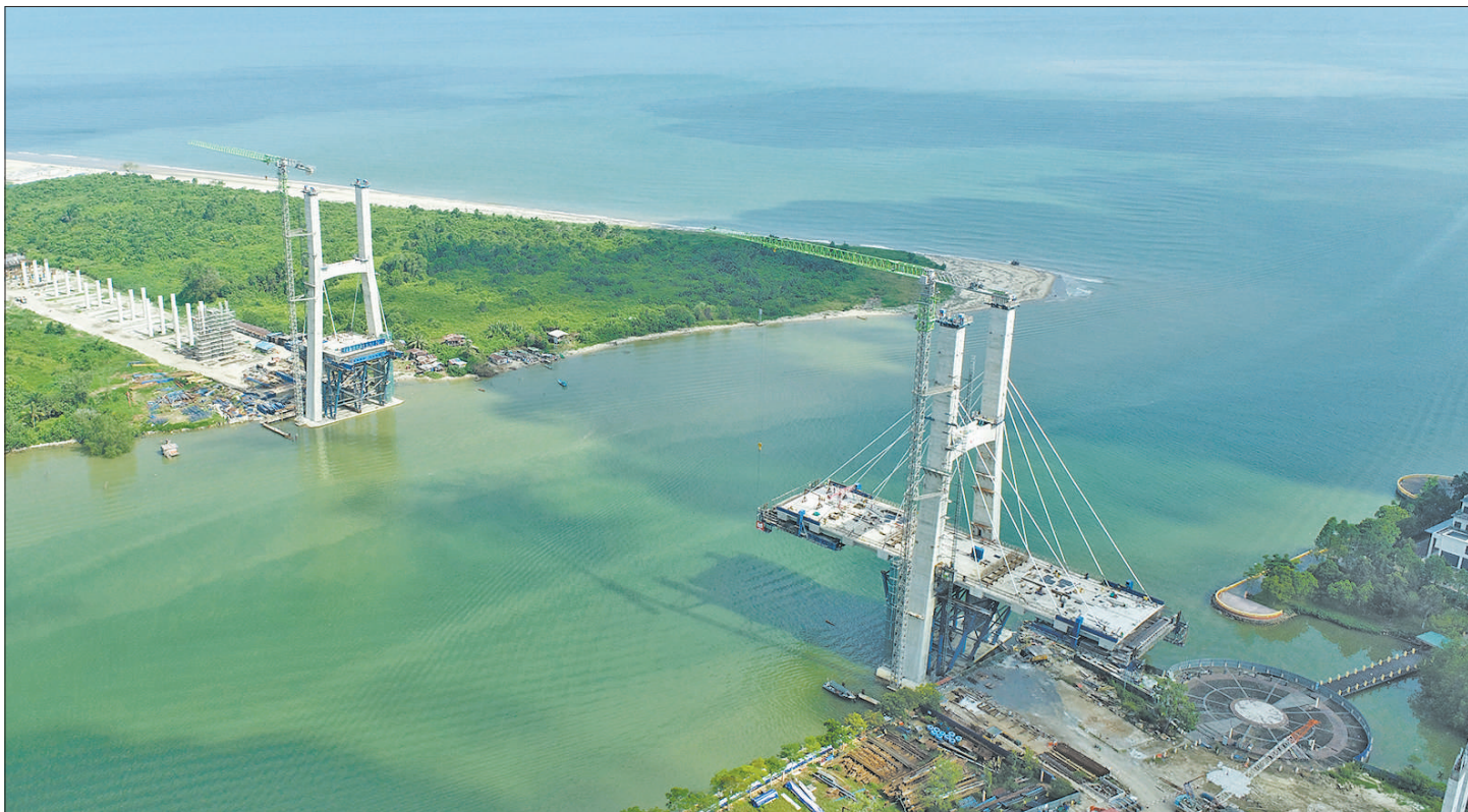
马来西亚萨拉越日拔大桥项目由中国交通建设(马来西亚)有限公司承建,是目前马来西亚境内最大的双塔双索面斜拉桥项目。大桥预计2024年10月完工,届时将连通民都鲁市区与民都鲁机场,为当地交通提供便利。图为大桥建设远景。郭苗苗摄
