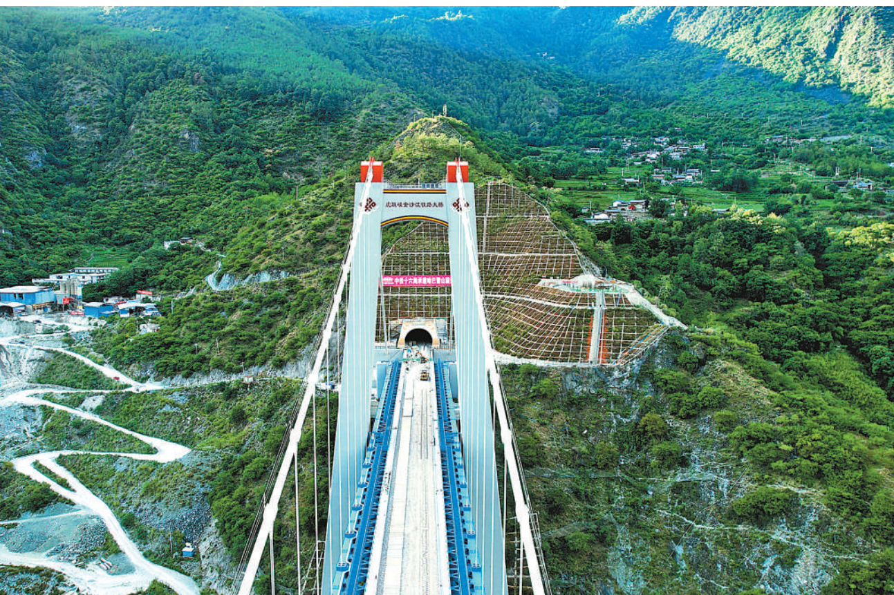
经过铁路建设者9年奋战攻坚，7月8日，滇藏铁路丽江至香格里拉段哈巴雪山隧道施工完成。至此，滇藏铁路丽香段20座隧道全部完成施工，转入长轨铺设阶段，为年内开通运营创造了有利条件。哈巴雪山隧道位于云南省迪庆藏族自治州，全长9.5公里，最大埋深1155米。隧道在建设过程中获得多项国家实用新型专利及发明专利，为高原铁路建设提供了有益经验。
