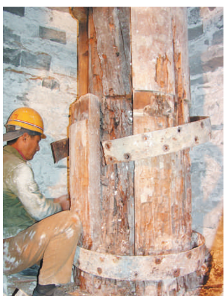
▲故宫太和殿内,施工技术人员正在揭露严重糟朽的柱根。周乾供图
