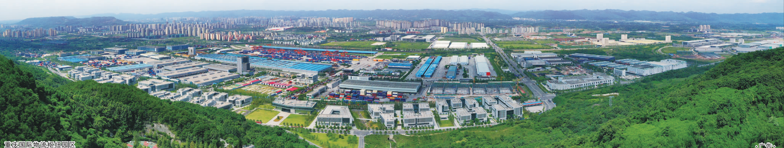
重庆国际物流枢纽园区
