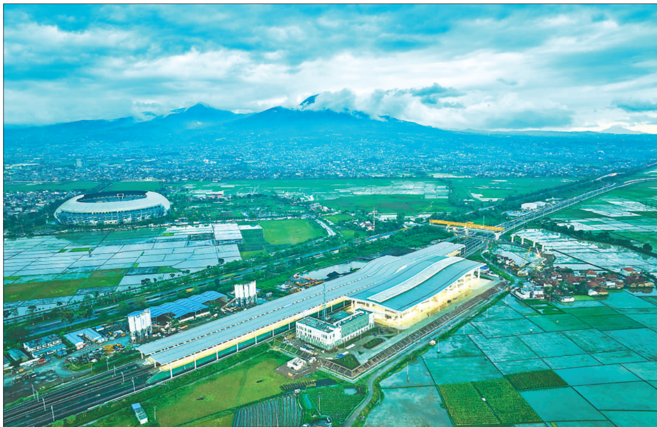
印度尼西亚雅万高铁德卡鲁尔车站由中国企业设计建设，建筑面积1.6万平方米，为半室外型站房，外观呈波浪形，遵循了“山水相融、自然之美”的设计理念。在中国建设者们的努力之下，目前车站站房主要精装修项目施工基本完成。图为6月27日，建设者在德卡鲁尔车站进行最后的扫尾作业。 史家民摄（影像中国）
