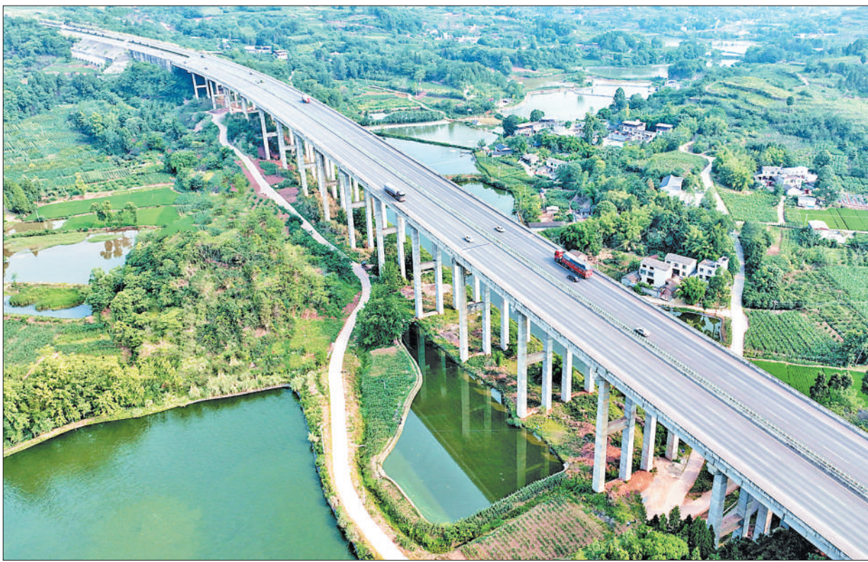
近年来,四川省眉山市仁寿县不断优化交通路网,方便群众出行,助力乡村振兴。图为日前拍摄的成都经济区环线高速公路仁寿段。
