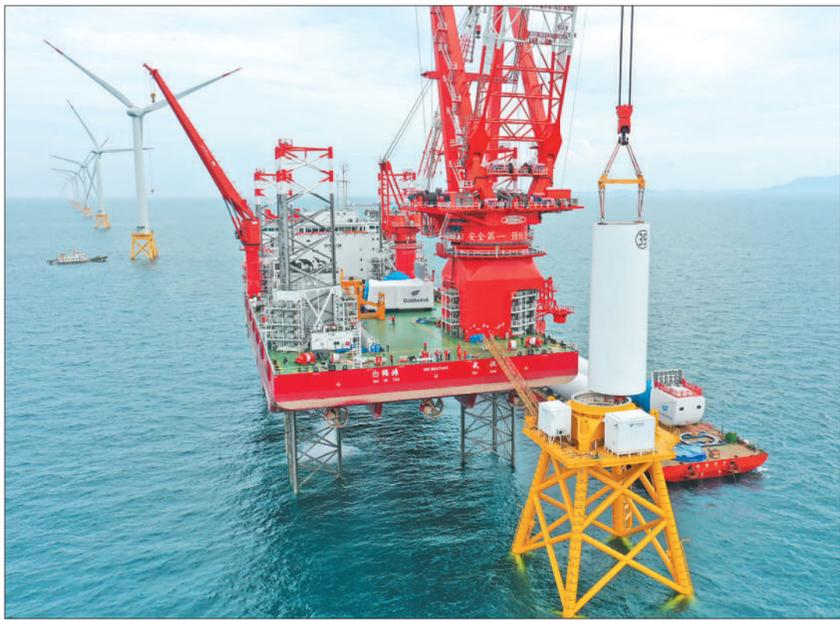
六月二十四日,在福建平潭外海,全球首台十六兆瓦大容量海上风电机组开始安装。图为海上风电安装平台“白鹤滩”号正在吊装塔筒。新华社记者 林善传 摄
