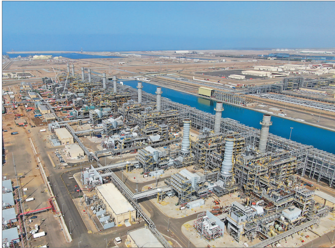
图为沙特吉赞燃气联合循环电站一景。
