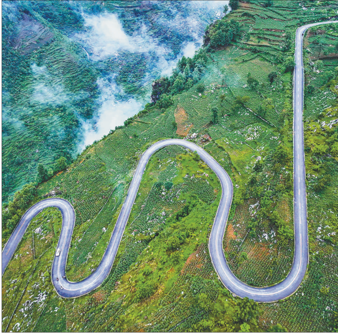
6月14日，贵州省毕节市纳雍县锅圈岩苗族彝族文化村，“四好农村路”蜿蜒盘旋，宛如一条丝带缠绕山间。近年来，当地“四好农村路”建设取得成效，串联起乡村交通路网，美化公路沿线景观，促进农业增效、农民增收，更好助力美丽乡村建设。
