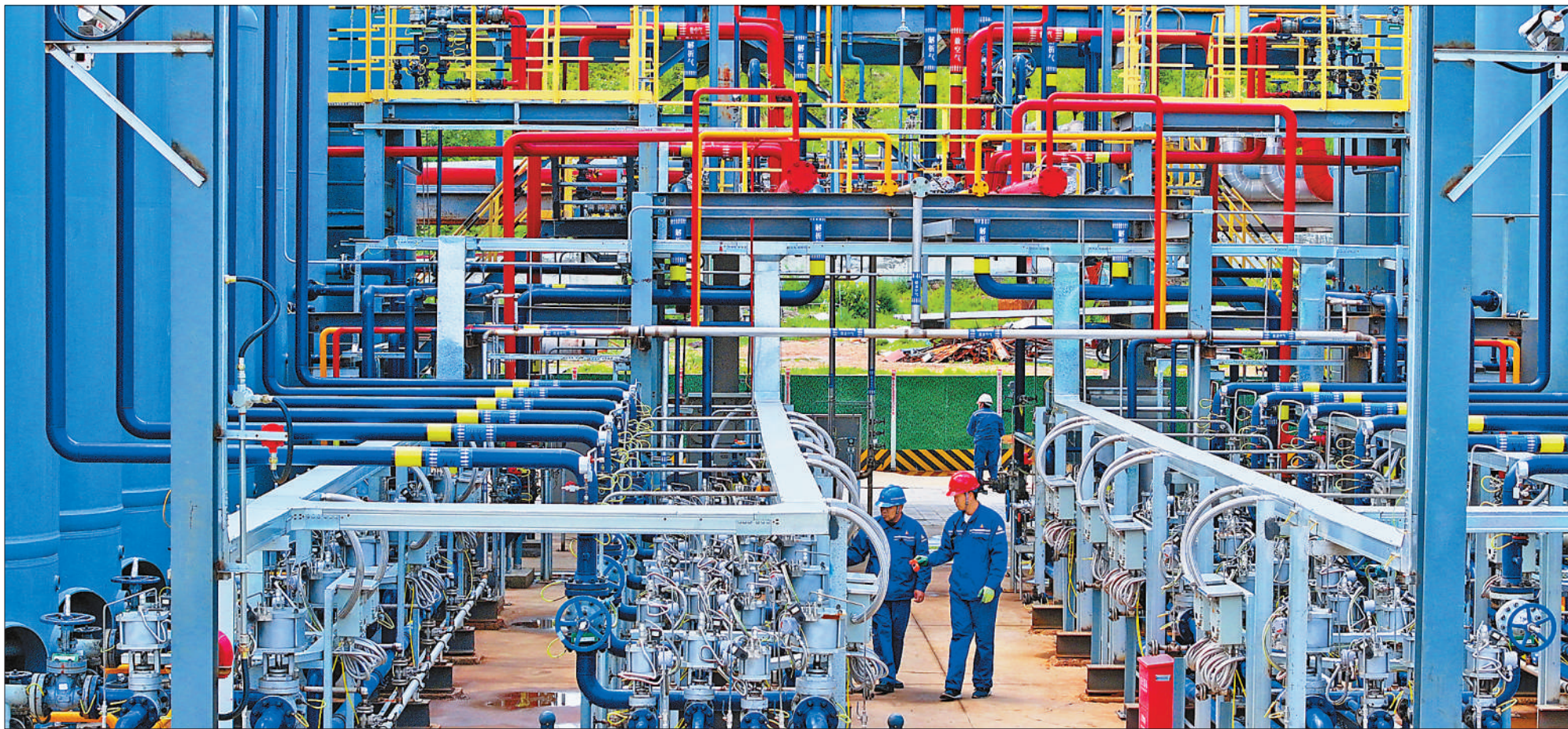
近年来，河北省迁安市凭借丰富的工业副产氢资源优势，积极布局氢能及氢燃料电池产业链。图为6月12日，位于迁安经济开发区的电池燃料氢项目现场，工人在氢气充装站检查氢气充装柱装备情况。董钧摄(人民视觉)
