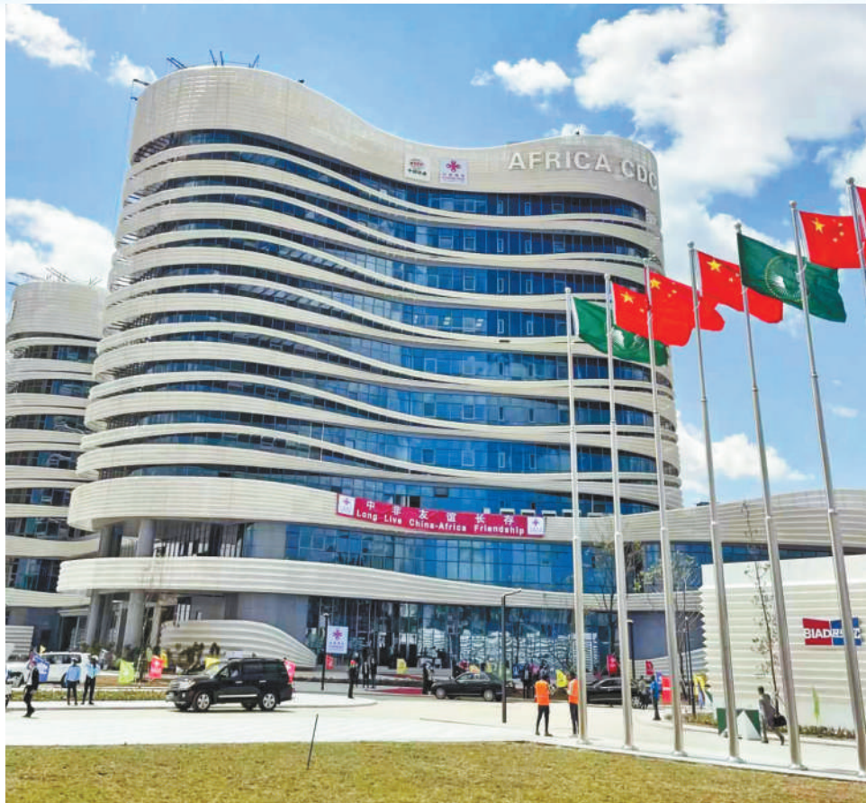
中国援非非洲疾病预防控制中心总部大楼。
