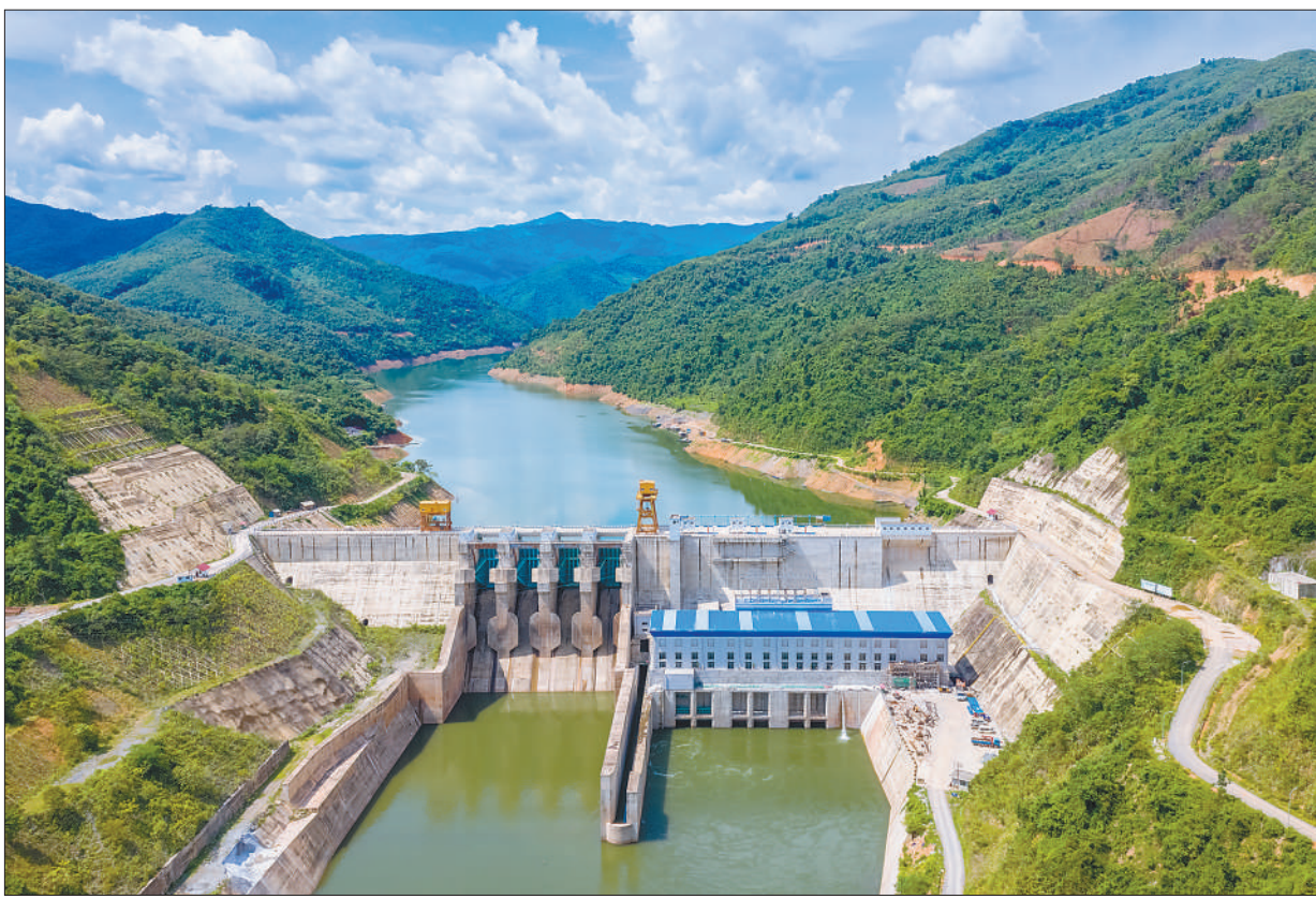
南欧江流域梯级水电电站项目位于老挝琅勃拉邦省和丰沙里省,由中国电力建设集团投资开发。项目投入商业运营以来,已成为老挝电网的骨干电站群,助力当地经济社会发展。
