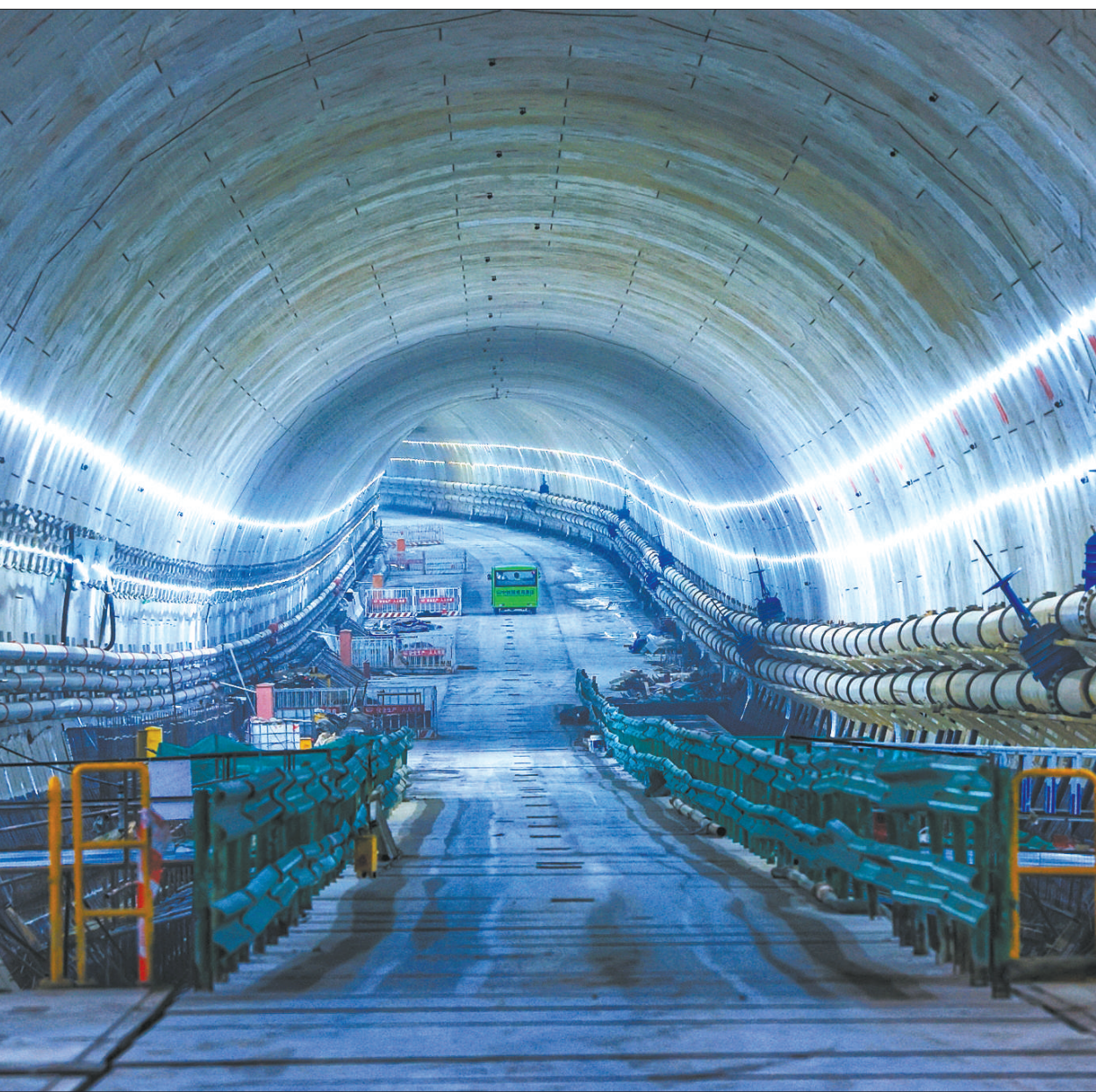
深圳首条跨海通道单线盾构贯通
