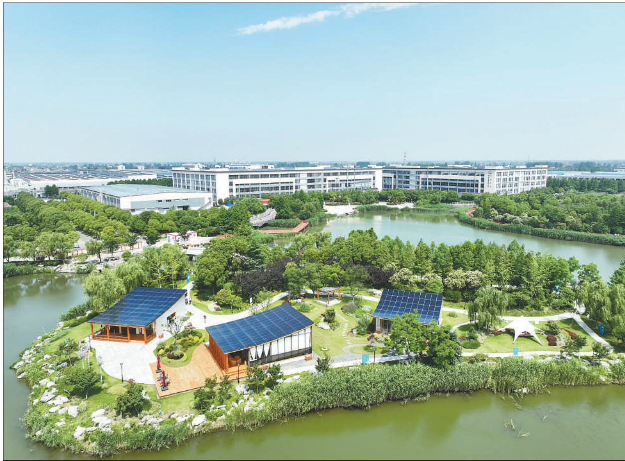
位于江苏泰州市海陵区新能源产业园区的“太阳里”城市客厅,占地面积达30亩,是海陵区重点打造的光伏应用示范项目。项目采用绿色、可回收、可降解材料,年发电量可达31万千瓦时,能实现年减排二氧化碳270吨,目前已成为市民参观、游玩的打卡地。图为“太阳里”城市客厅外景。顾继红摄(影像中国)
