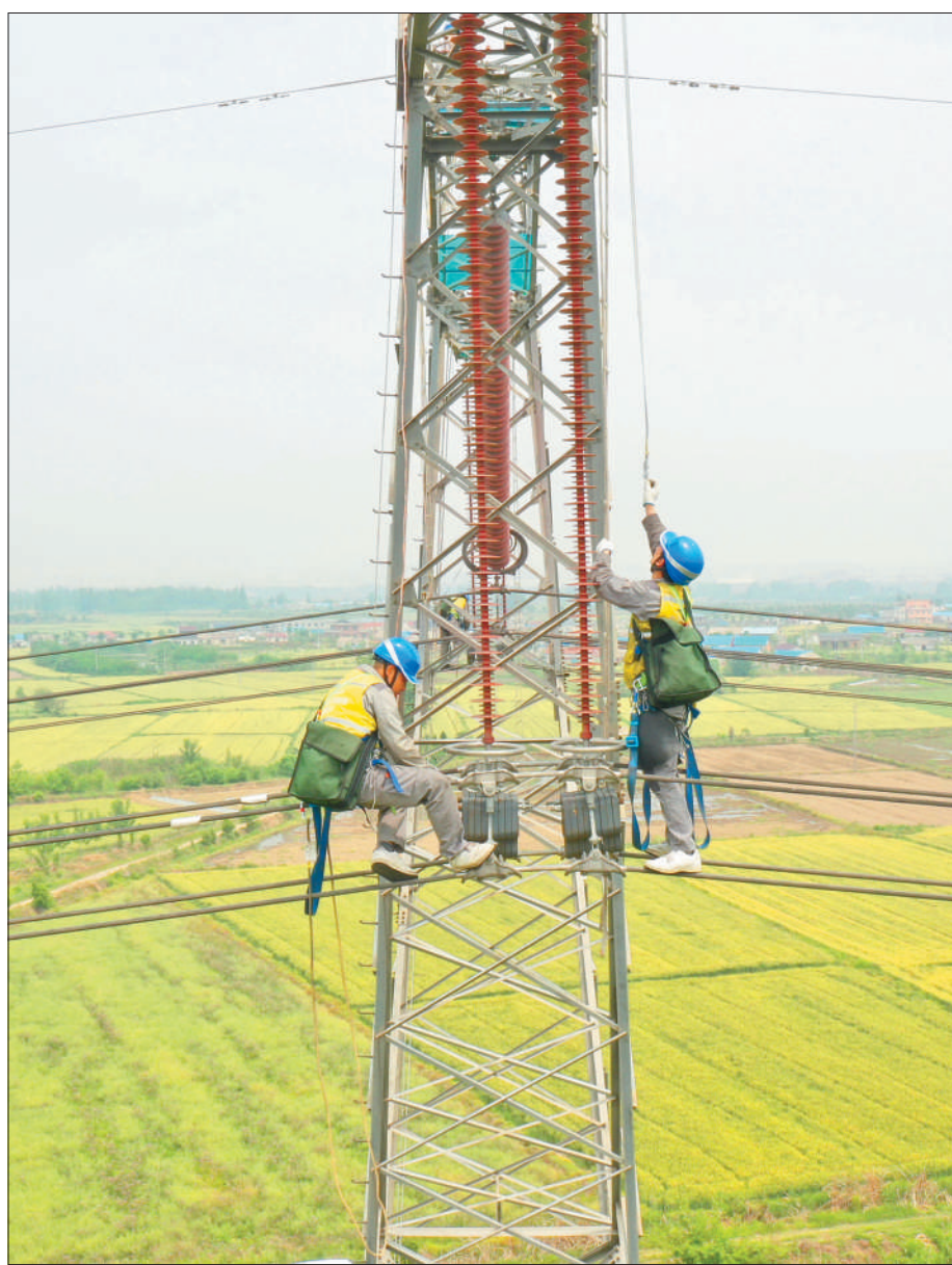
安徽省滁州市定远县严桥村,检修人员对输电线路进行综合检修。
