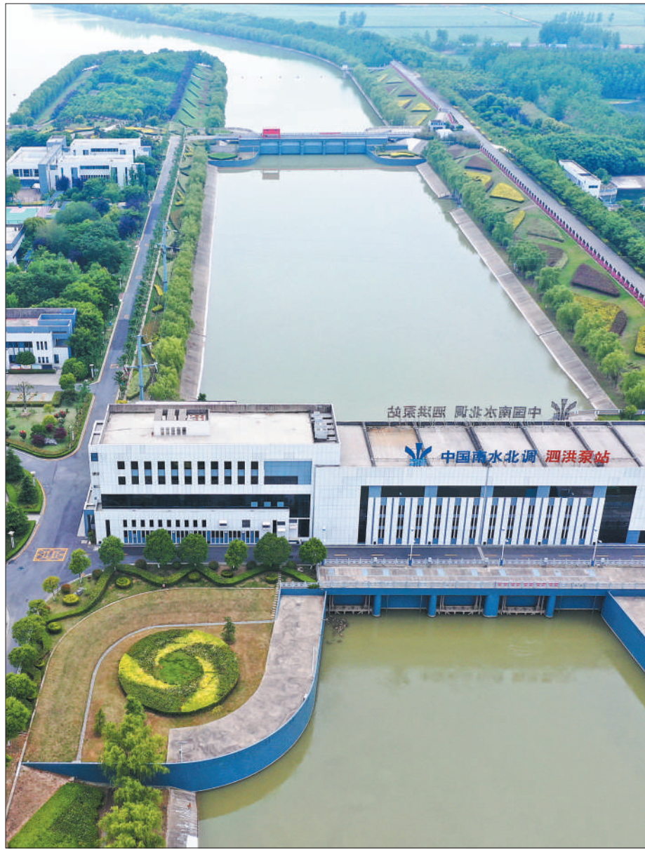
位于江苏省泗洪县的南水北调东线一期工程泗洪泵站。
