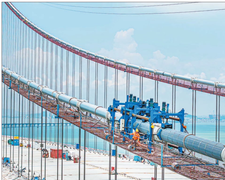
6月4日，工人在深中通道伶仃洋大桥主缆上进行缆索加固。作为粤港澳大湾区超级工程，深中通道正在加快建设。当前，桥梁工程正全面开展桥面铺装及附属结构施工，向2024年建成通车发起冲刺。 本报记者 张武军摄
